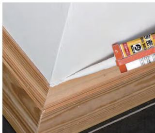
收边美容 修补裂缝
